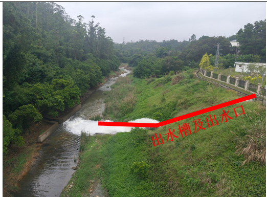
出水槽及出水口
